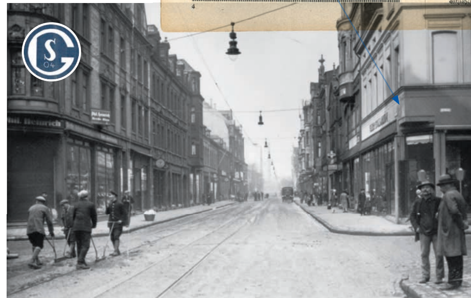
SPUREN: Schalker Straße 158-160: Wohnhaus und Ladenlokal (Rundgang 1)
